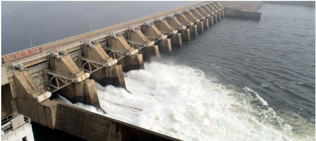
Barrage hydroélectrique de Kpong (Ghana).
