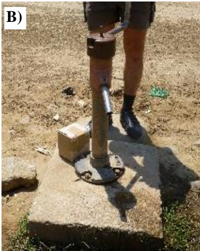
Figure I.24 : Photos illustrant l'accès aux eaux souterraines à Potshini. A) Source provenant de l'aquifère multicouche du Beaufort et B) Pompe à main prélevant dans la nappe de l'Ecça
