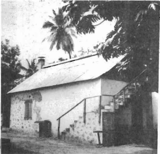
2 - "Calorifère" à coprah aux Seychelles. Escalier de visite à l'extérieur.
