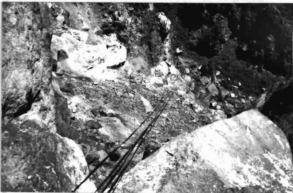
Photo 15: Passage aérien sur les lignes C et TS; le site C est visible.
