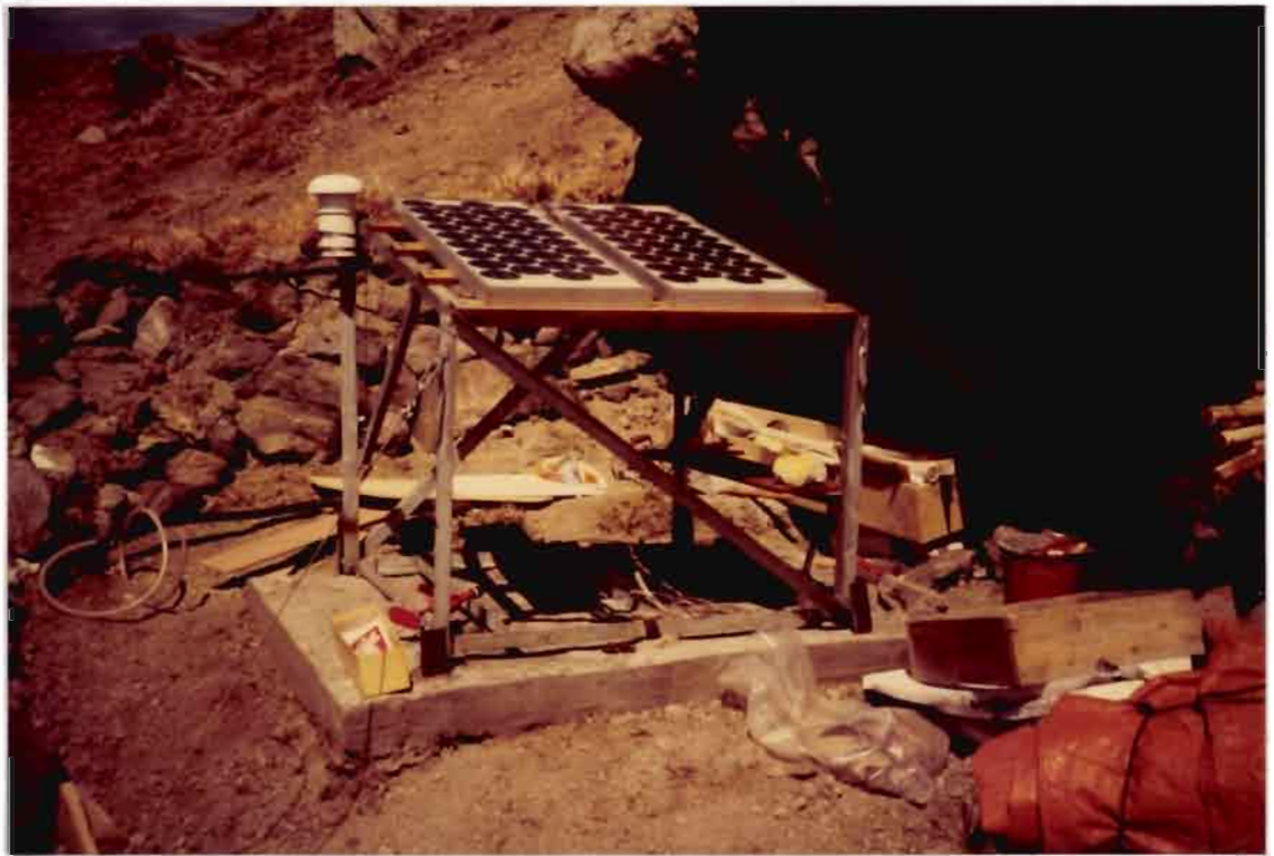
Photo 3 : la station en cours de montage = dalle, panneaux solaires, abri météorologique ....
