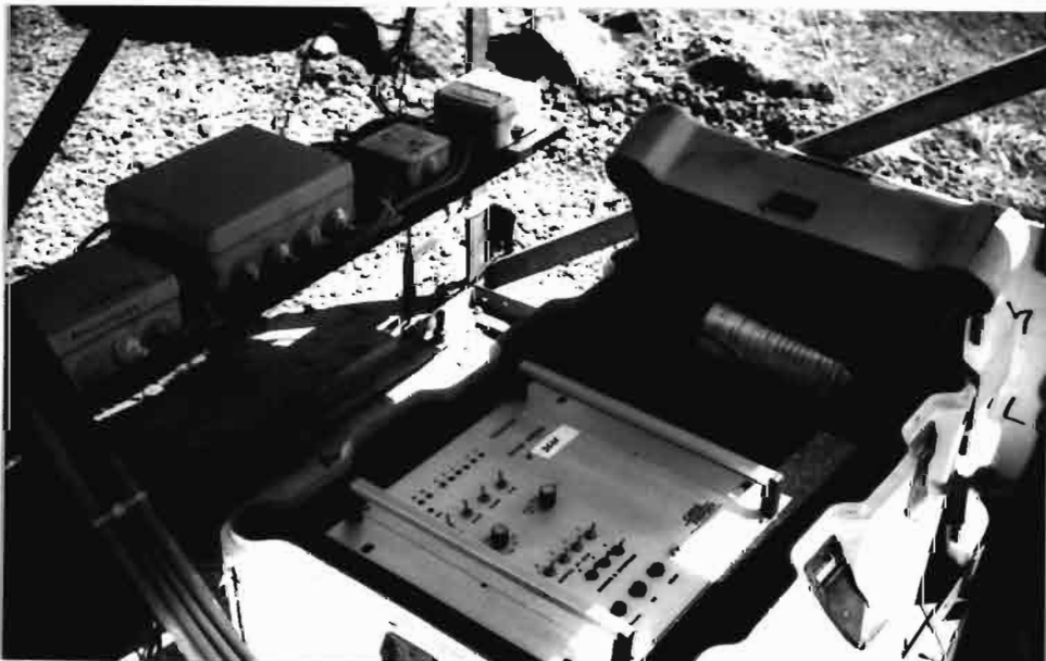
Photo 5 : la station SADAN et les 4 boîtes de connexions étanches
