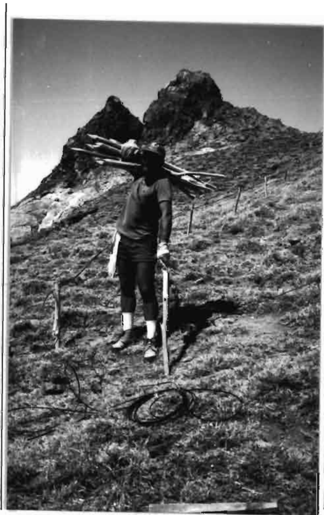
Photo 9 : installation des lignes A et B
