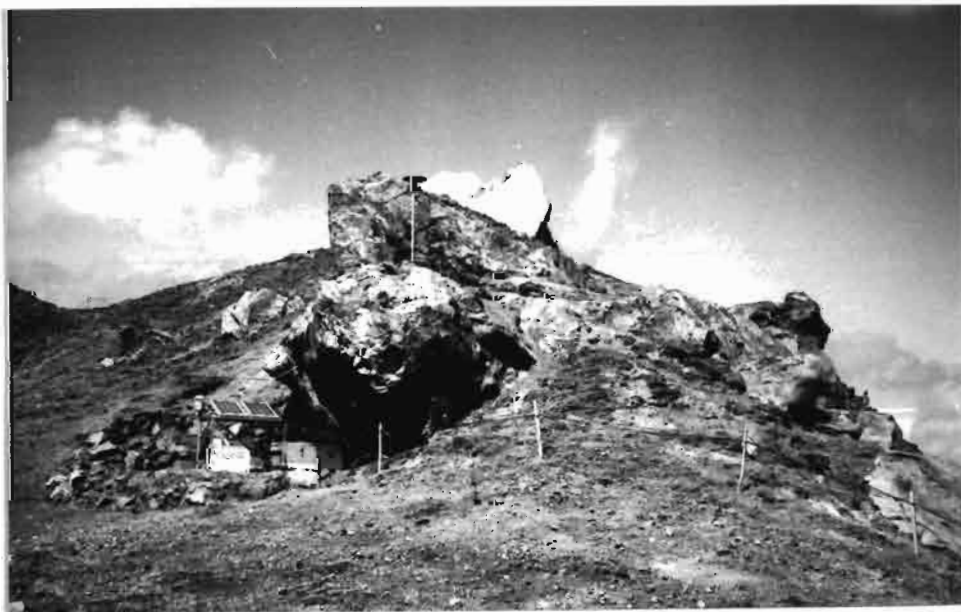
Photo 2 : vue générale du site d'installation de la station
