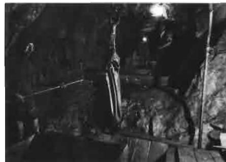
Caja 11. B 913 Mina Socavón, excavación de agua, Pozo central, 9na galería.
