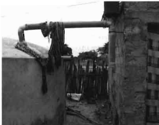
Figure 6 : Citerne de stockage de l'eau de pluie à Falia (2015)
