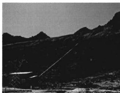
Annexe 14 : Tuyau d'arrivée d'eau (Centrale Tiquimani-Vallée Zongo)
