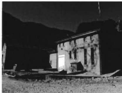
Annexe 8 : Centrale Zongo (Vallée Zongo)
