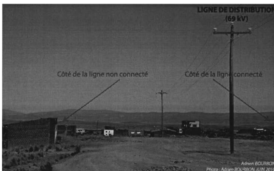
Photographie 1: Foyers non connectés bien que situés juste devant une ligne de distribution (Quartier Bella Vista, District 7, El Alto)
