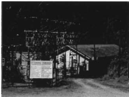
Annexe 7 : Centrale Chururaqui (Vallée Zongo)
