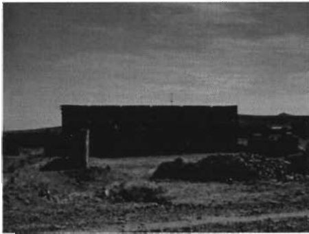
Annexe 26 : Habitation en construction ne disposant pas encore de l'électricité (District 7 - El Alto)
