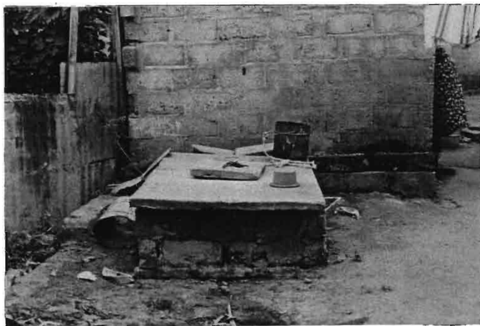
Photo. 10: Puisard limité par une paroi en parpaing et collectant essentiellement les eaux de toilette.
