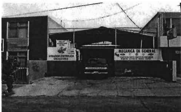
Atelier de réparation mécanique
