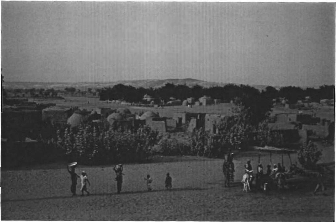
Photo 8 : Le quartier Sabon Guida de Tamaské, coupé en deux par un Kori en voie d'élargissement
