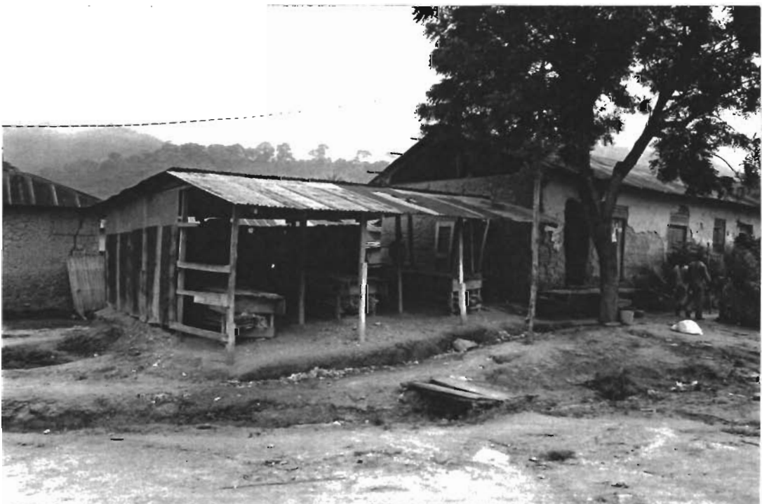
Photo 2 : Un atelier de menuiserie occupe une parcelle anciennement bâtie dans le quartier originel. Le ravinement et la dégradation du bâti sont avancés
