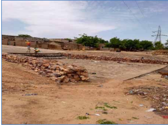
Figure 4. Pavé stabilisé à l'exutoire
