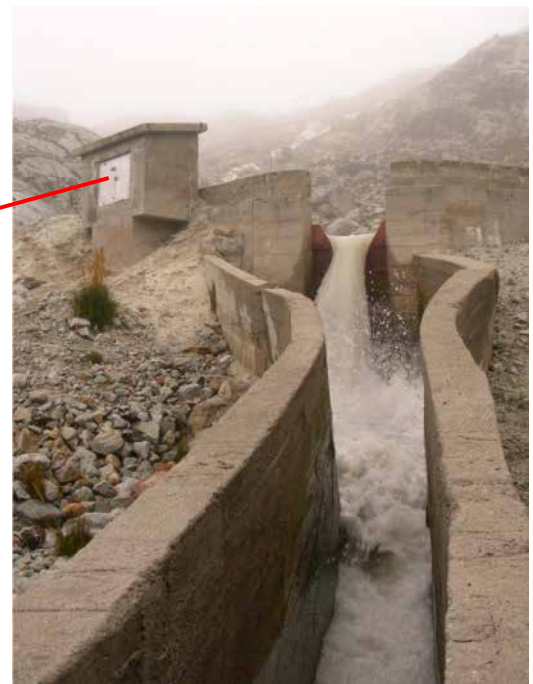
Figure II 5.- A gauche Centrale d'acquisition type «Limni 92» surmontée d'un panneau solaire (Caballero, 2001). A droite la station limnigraphique à 4830 m.s.n.m. (Photo : Leonardini, 2009)
