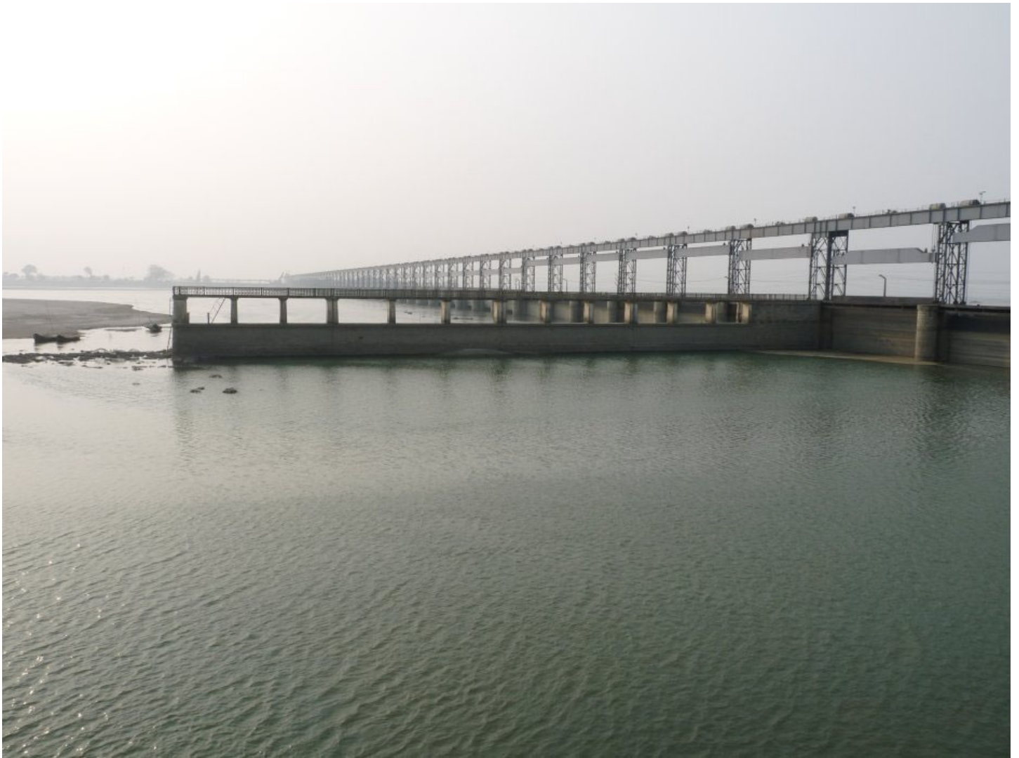
Le barrage de la Koshi, localisé au Népal à la frontière avec l'Inde, sert à réguler le flux de la rivière pour éviter les inondations et à dévier l'eau pour l'irrigation de terres situées essentiellement en Inde. Le barrage est d'ailleurs géré par les ingénieurs indiens. (Photo O. Aubriot 2010)
