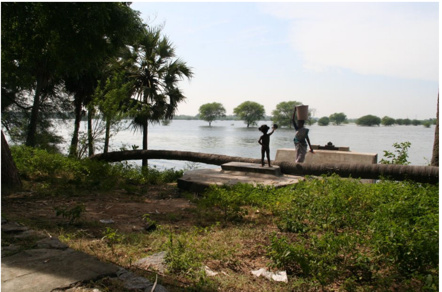
« Tank » ou étang semi-endigué de l'arrière-pays de Pondichéry. La vanne au centre de la photo contrôle le flux d'eau à délivrer aux canaux en aval. Le remplissage de l'étang est saisonnier : six mois plus tard il est à-sec.
