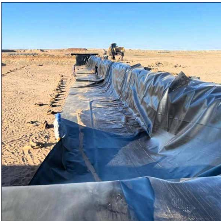
Illustration 5 - Site de traitement à Sféryat
