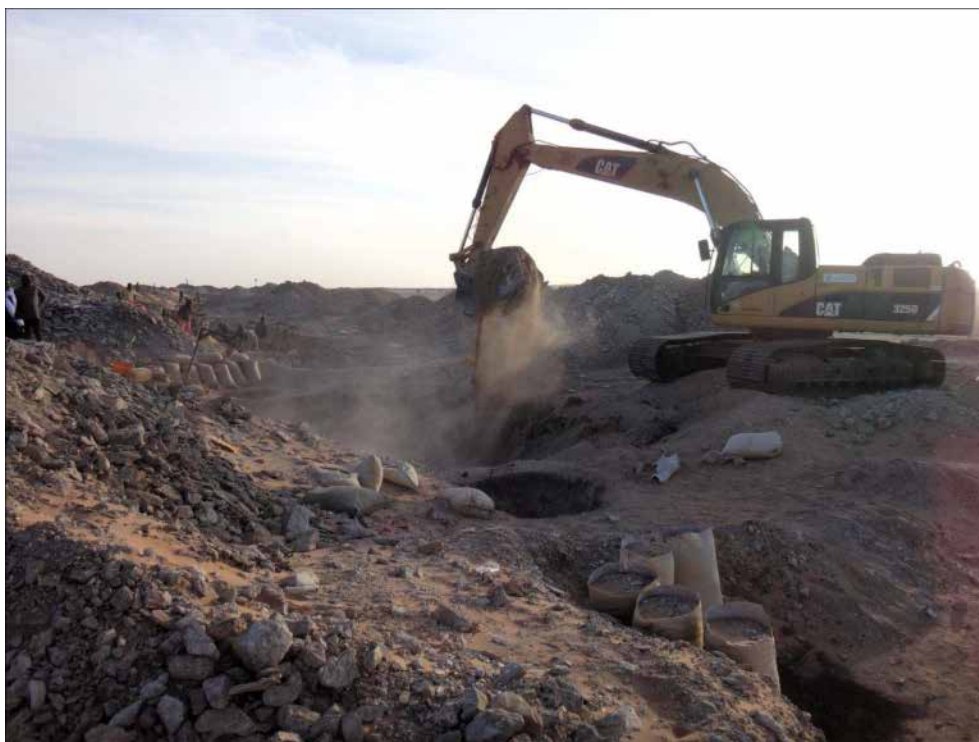
Illustration 6 – Pelle mécanique hydraulique sur un site d'orpaillage
