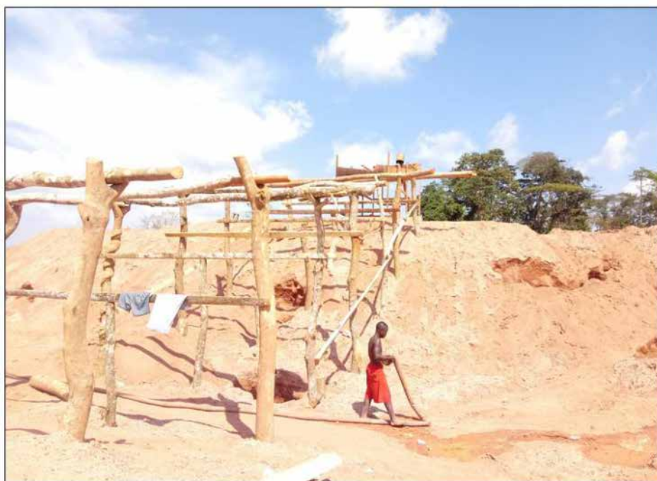
Illustration 2a - Le dispositif technique d'extraction des résidus aurifères en construction
