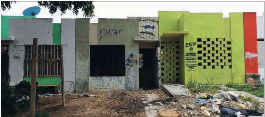
Fig. 9. Dans la commune de Tlajomulco, un programme municipal inspiré d'une initiative des habitants consiste à protéger les logements abandonnés en les scellant au moyen de briques et en y apposant un logotype et un avertissement.
