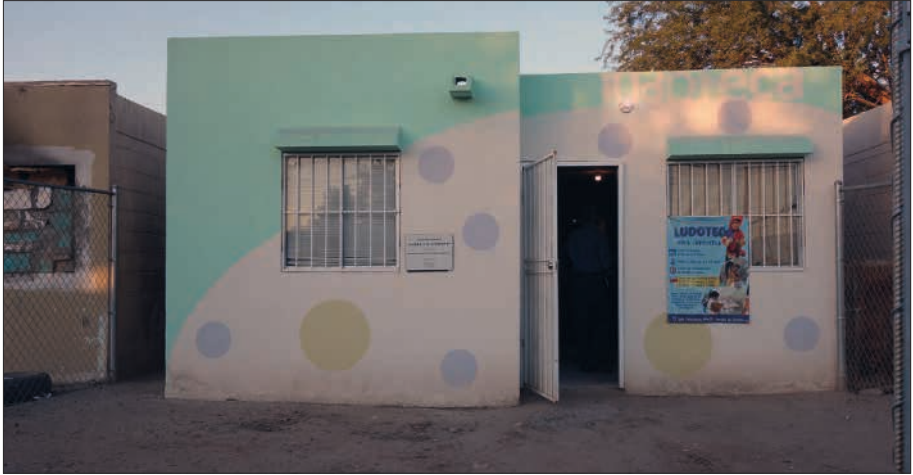
Fig. 12. À Mexicali, dans le secteur Los Pueblos, à côté d'une maison abandonnée, incendiée et murée, un logement a été récupéré par l'INFONAVIT, puis transformé en ludothèque publique dans le cadre du nouveau programme Regeneración Comunitaria INFONAVIT .
