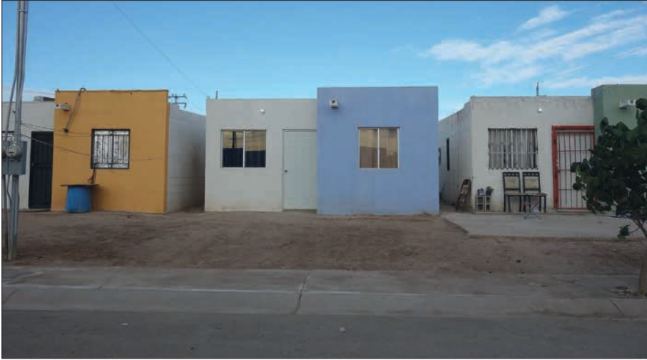
Fig. 2. L'un des prototypes de logement utilisé et répliqué à l'identique dans le secteur Los Pueblos, à Mexicali, ville frontalière avec les Etats-Unis. La superficie est très réduite (35m 2 ) et le design basique, peu propice à des adaptations.
