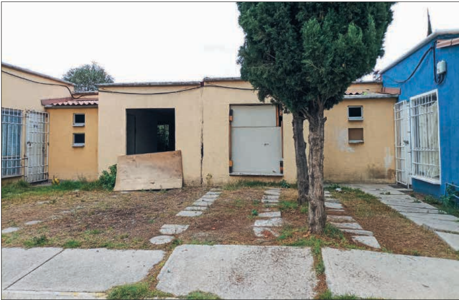
Fig. 13. Dans la commune de Zumpango, deux logements propriété de l'INFONAVIT en passe d'être réparés suite au départ de leurs occupants sans droit ni titre. Afin d'éviter une nouvelle occupation irrégulière, l'entreprise prestataire a conclu un accord avec les voisins pour qu'ils surveillent les constructions.
