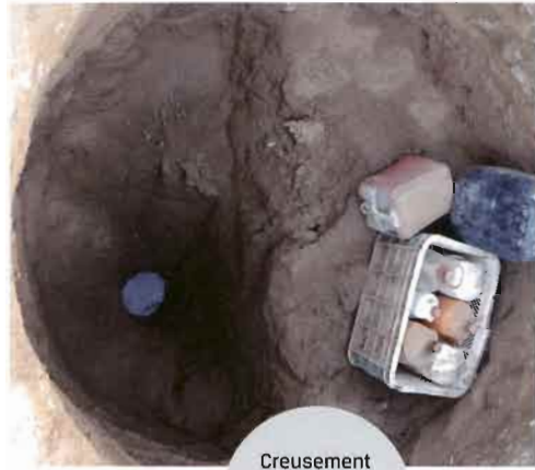
Creusement à la main d'un puits dans le Tafilalet (Maroc).
