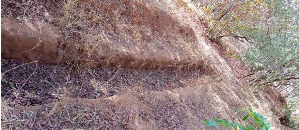
Photo 8 Une tranchée d'infiltration
