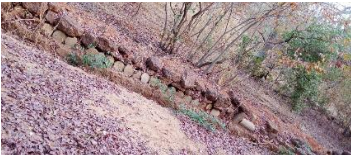
Photo 9 Une tranchée en amont d'un cordon pierreux
