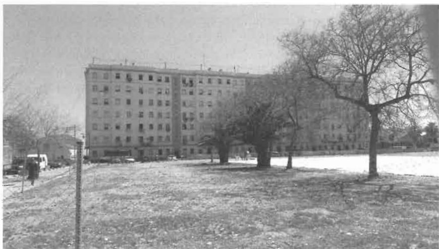
Fig. 3 – El Bloc-dels-Portuaris. Source : F. Torres, avril 2016.
