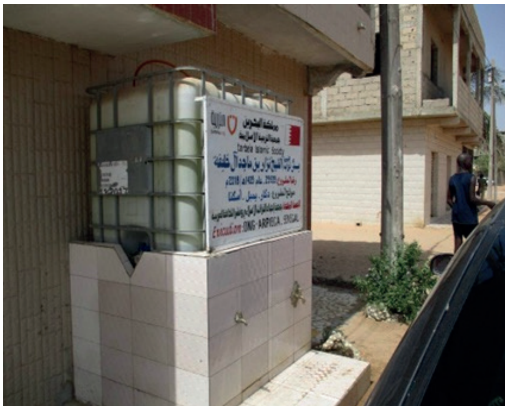
Photo 10- Pompe électrique équipée de robinets à la Cité COMICO 4
