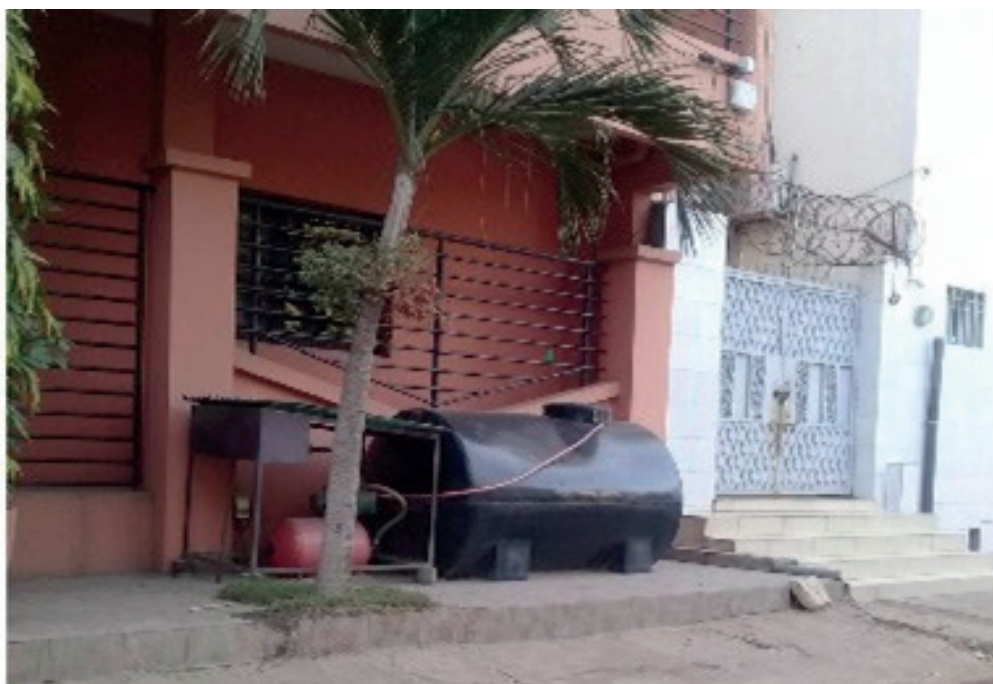
Photo 2 - Réservoir de stockage équipé de suppresseur à Hann Maristes 1
