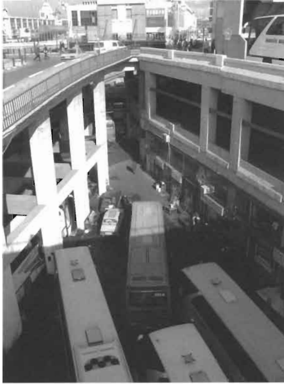
Photo 1 – Tranchée au cœur du dispositif
