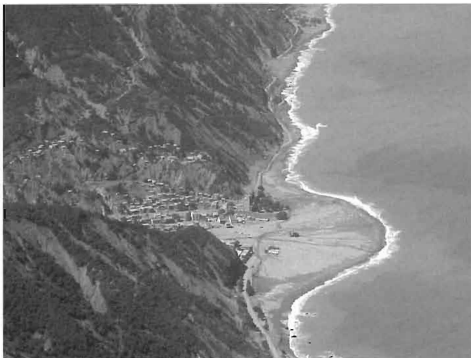
Photo 1 – Les fortes pentes du littoral central vénézuélien et les constructions dans les lits des rivières et sur les cônes de déjection. Ici, la ville de Carmen de Uria, après les coulées de boue de 1999
