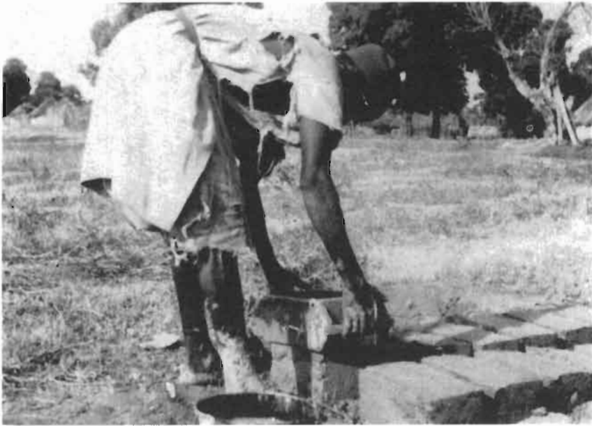
Photo 5 – Construction d'une case : moulage des briques de banco (© E. Bernus, 1956)
