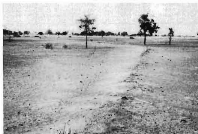
5 — Dégradation d'un aménagement antiérosif de versant (Sabouna — nord de Ouahigouya). Matériau sableux poussé à l'ouest (à gauche) du bourrelet.
