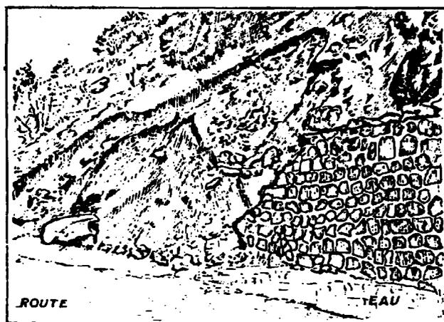
FIG. 14. — Aval de Thuiles (Ubaye) N100. Effondrement d'un mur de soutènement mal conçu. Forte thixotropie au-dessus de la partie du mur qui a résisté.
