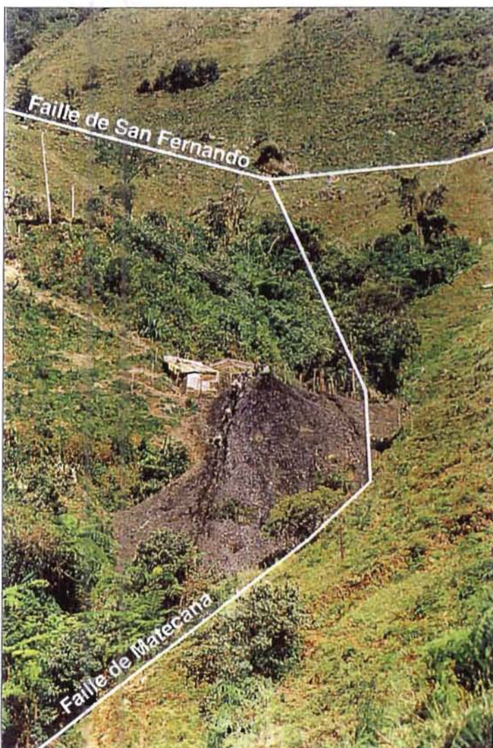
Figure 13. Le site de Matecaña. Les déblais, extraits de la galerie, sont déversés dans le ravin à l'entrée de la galerie. Les failles de San Fernando et de Matecaña sont matérialisées. À l'entrée de la galerie, les abris de tôles protègent le compresseur pneumatique et l'équipe qui veille à la sécurité de l'exploitation. Photo V. Castañeda.
