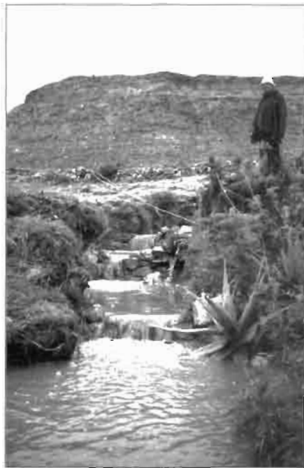
Figure 6. Un ravin contrôlé efficacement, 10 minutes après une averse intense en juillet 2000. L'eau stagnante entre les check dams absorbe l'énergie de la chute et protège la base du barrage (photo M. Veyret-Picot).
