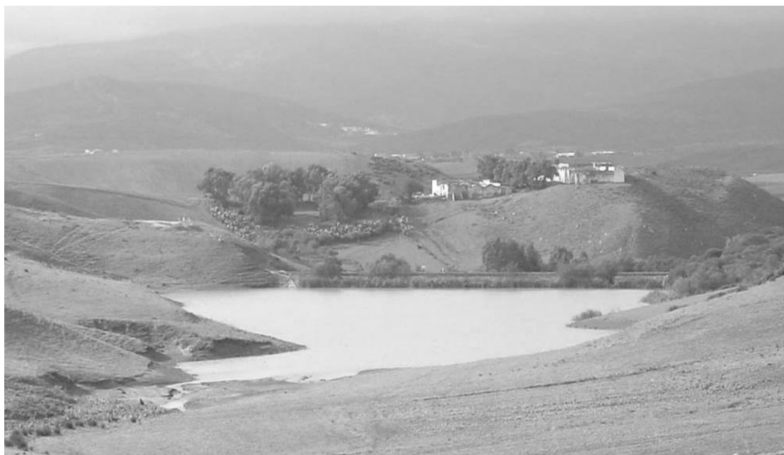
Figure 1 : Lac collinaire de Kamech au nord du Cap Bon en Tunisie (© Albergel). Hauteur du barrage 10m ; volume du réservoir 142 560m 3 , surface maximale du lac 44 500m 2
