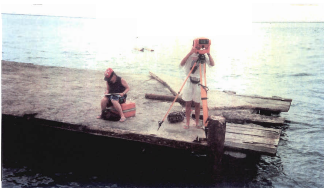
Photo 2 : Mise en place du géodimètre
