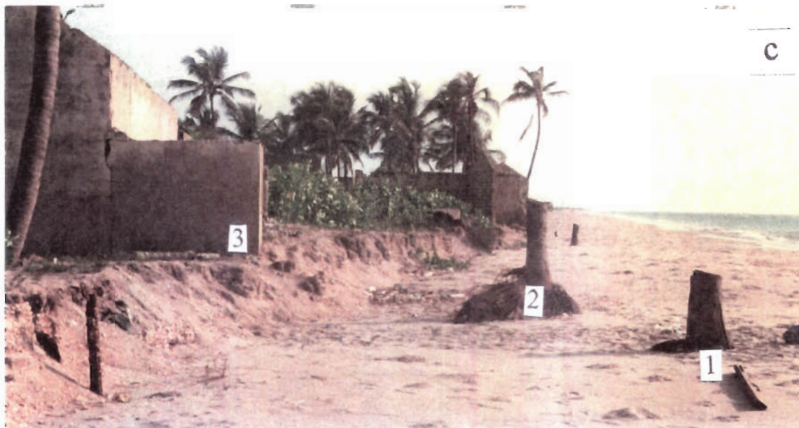
Photos 22 a, b et c : Recul de la ligne de rivage à Palmarin entre octobre 1989 et novembre 1996 La plage a reculé de 7 à 8 m entre octobre 1989 (a) et octobre 1995 (b). Entre octobre 1995 et novembre 1996 (c), le profil s'est stabilisé.
