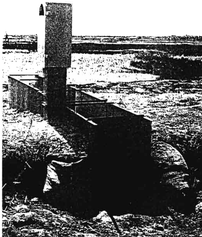
Quelques jours avant la rupture de la digue...
