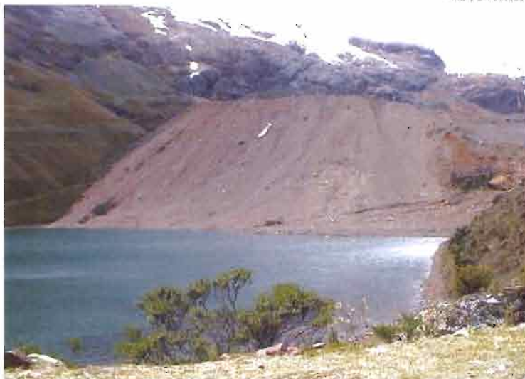
Safuna Baja y la morrena de Safuna Alta erosionada por el desbordamiento de la laguna
