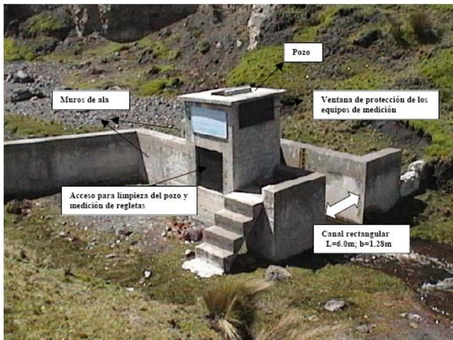
Figura 6.14. Conformación de la estación hidrológica Humboldt
