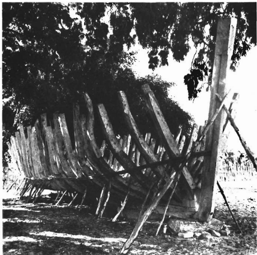
Belo-sur-Mer. Goélette en construction
