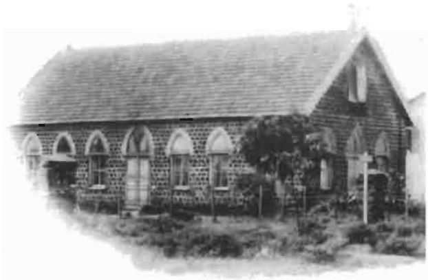
Un exemple de construction en 1900 : l'église anglicane de Conakry.
