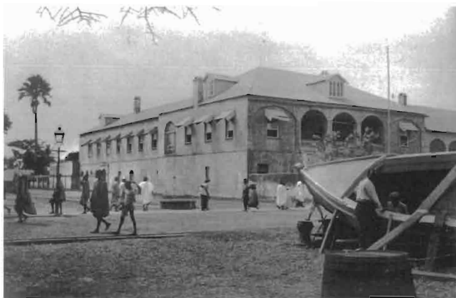
Ancien immeuble Miriam et C ie , Wellington Street, Banjul.
