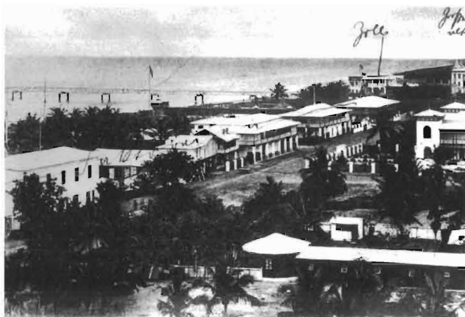
Vues panoramiques sur l'ouest de la ville de Lomé, 1908.
