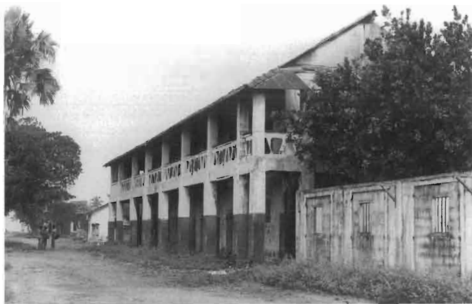
Le bâtiment de la Woodin & C e à Grand-Lahou.
