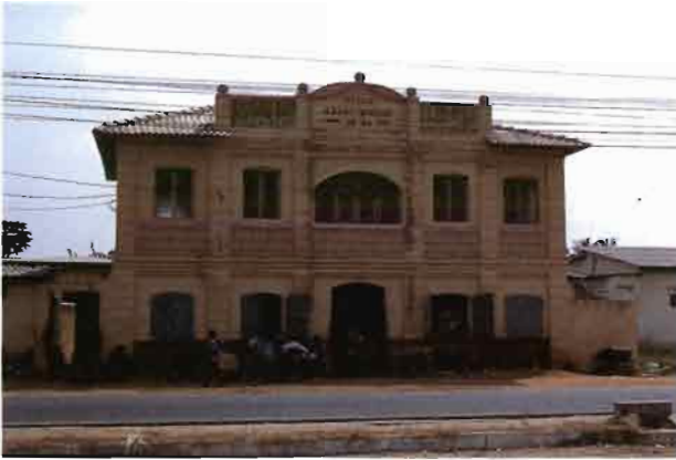
Aného, habitation construite en 1924.
