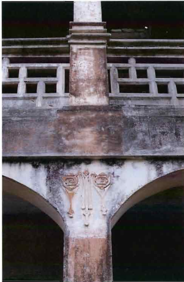
La maison Rhodes, détail de pilier et de balcon.
