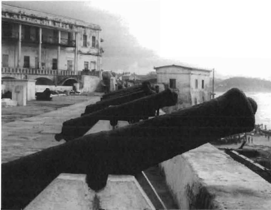
Terrasse et batterie du château de Cape Coast.
