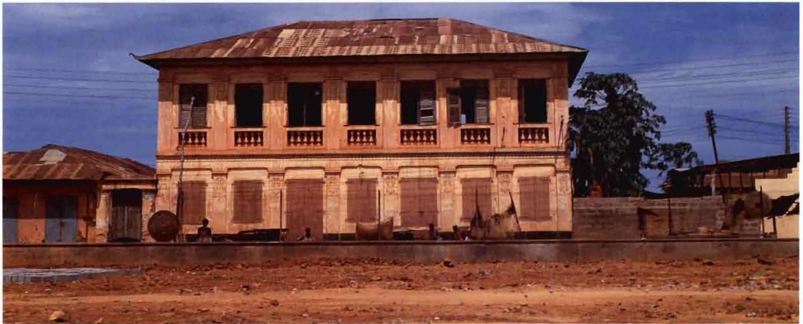
Un bâtiment du type « Maison de Commerce » en face du marché Zobé.
