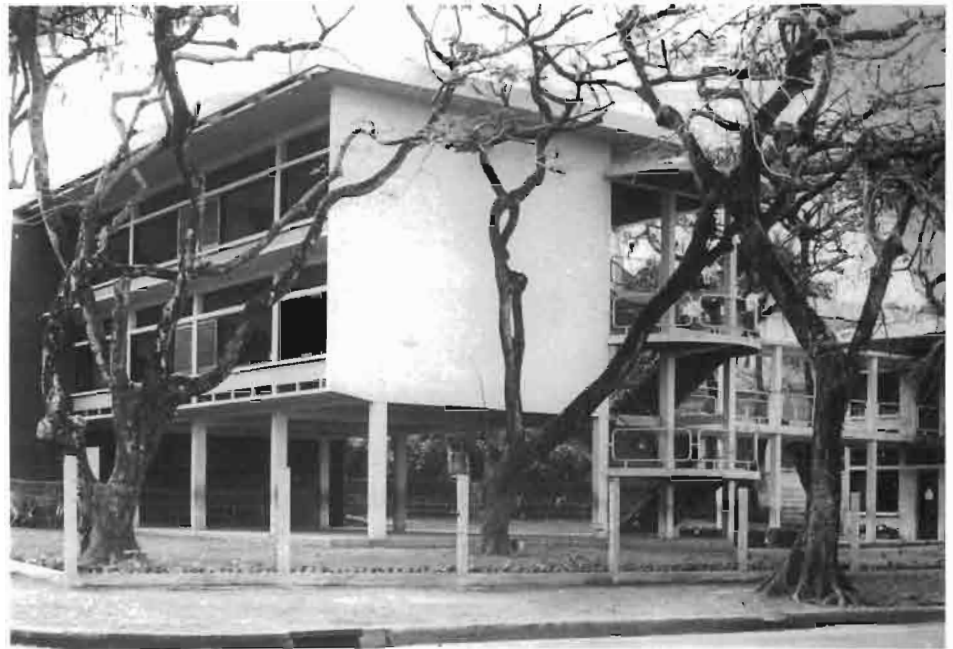
Conakry, bâtiment scolaire construit dans les années cinquante.
