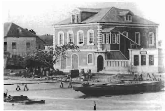
La marina de Lagos vers 1900 avec les maisons de commerçants.
