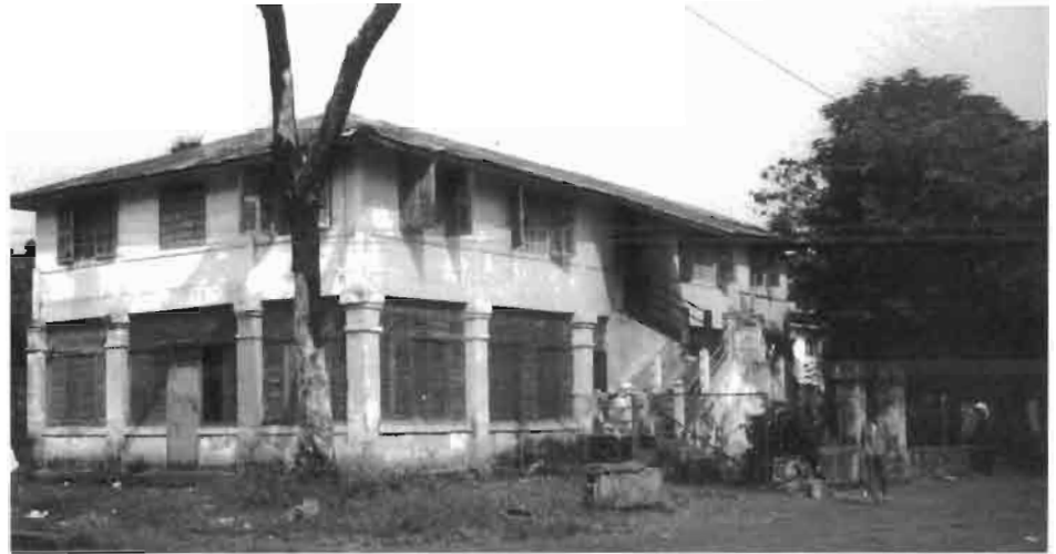
Ville «rose» construite en 1936 pour deux fonctionnaires.
