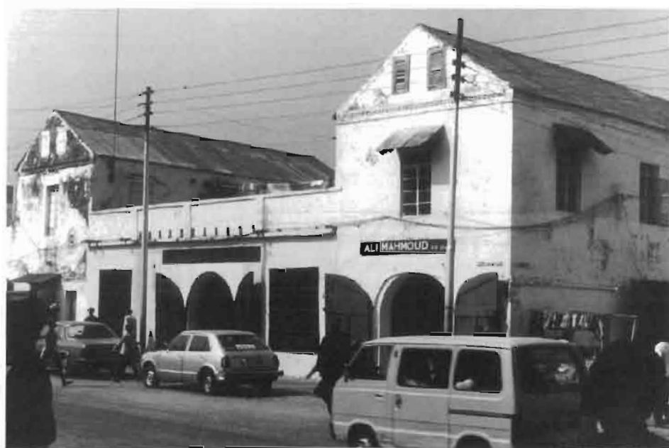
Ancien bâtiment des frères Maurel, Wellington Street, Banjul.
