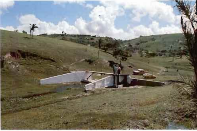
Station de mesures. Bassin versant d'Angelim. Nordeste brésilien.
