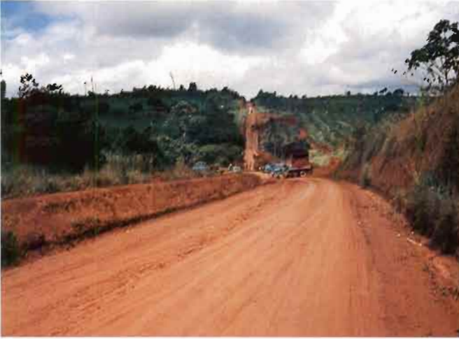
Travaux d'aménagement de la Transamazonienne.
