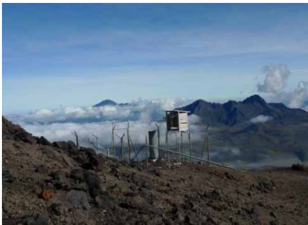
Figure 12: Station météorologique installée à 4 800 mètres sur le Cotopaxi
