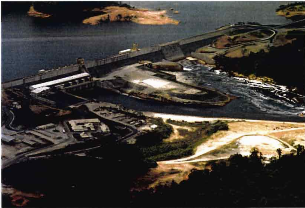
Photo 9 : Le barrage de Petit Saut (The Petit Saut dam) (A barragem de Petit Saut)
