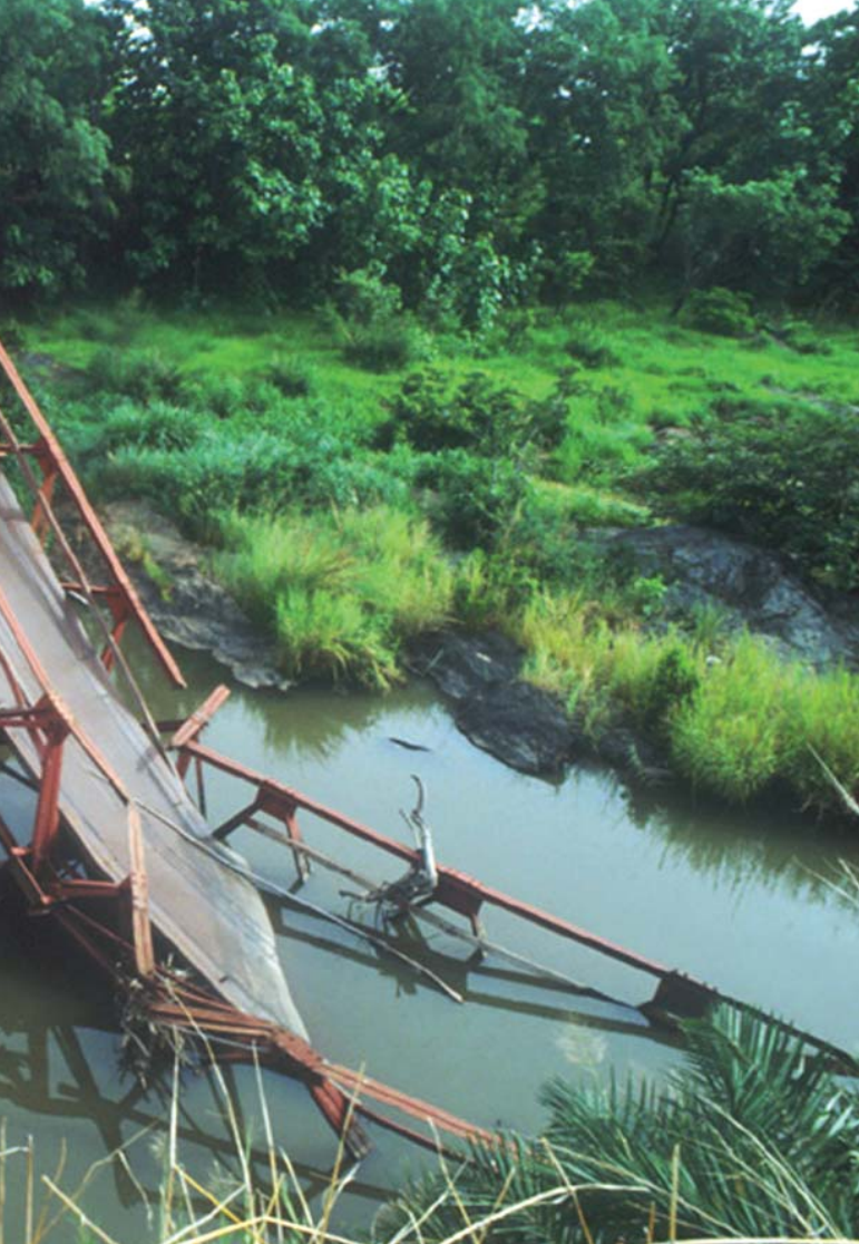
▲ Togo, Région centrale. Effet hors-site de l'érosion hydrique. Ce pont a été détruit par une forte crue dans un bassin versant très érodé. La zone desservie par le pont risque d'être enclavée durant des mois ou des années.
