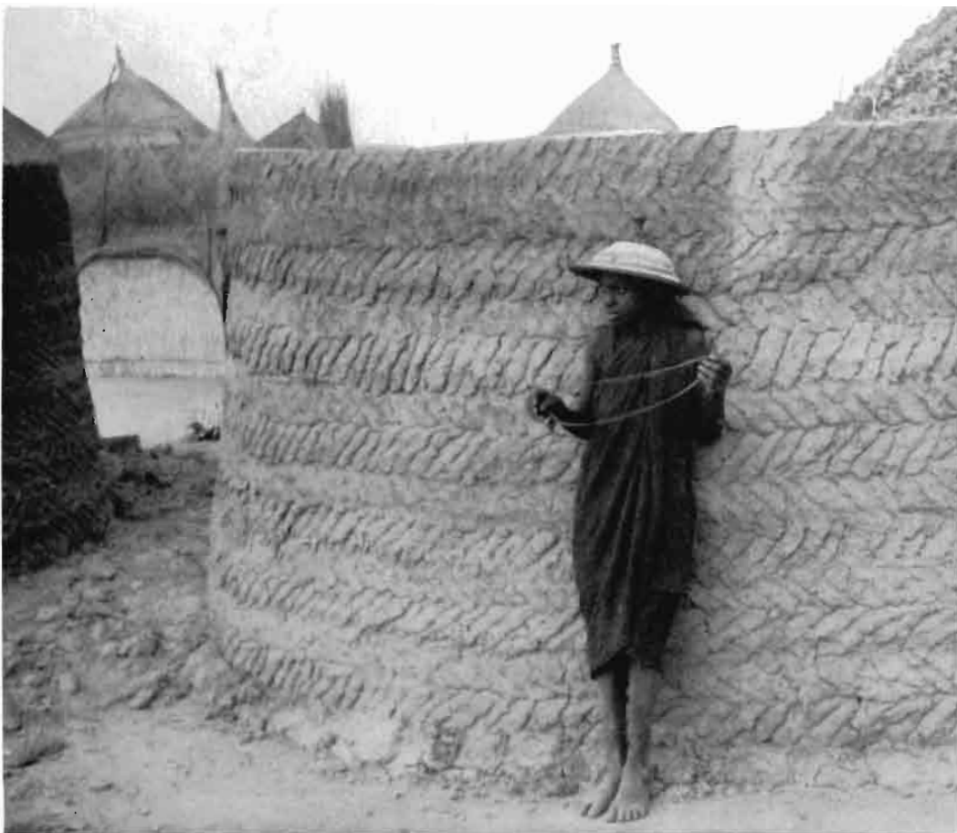
15. Construction d'une case. Des mottes de terre disposées en chevrons.
