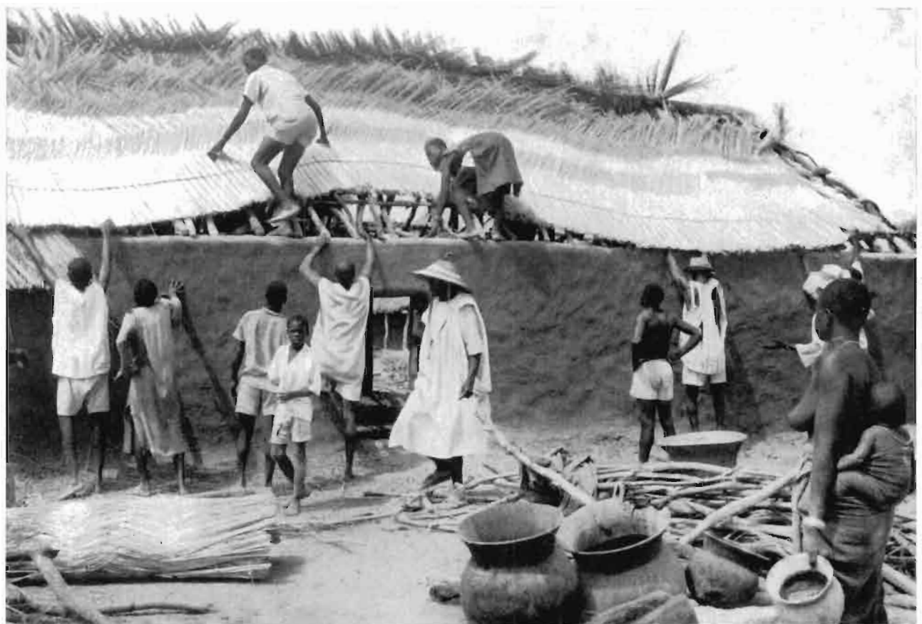
17. Construction d'une case. Un papwogu .
