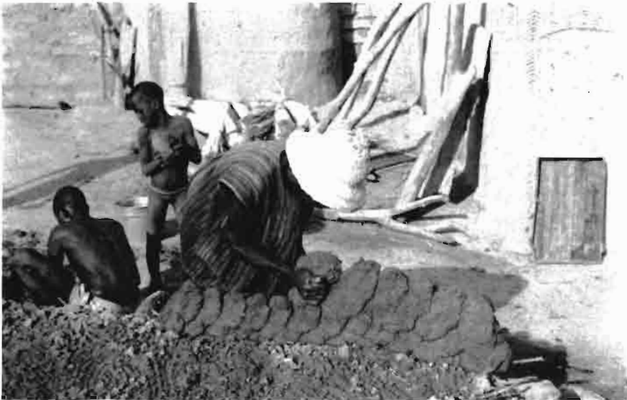
Les différents stades de la construction d'un grenier à mil.
