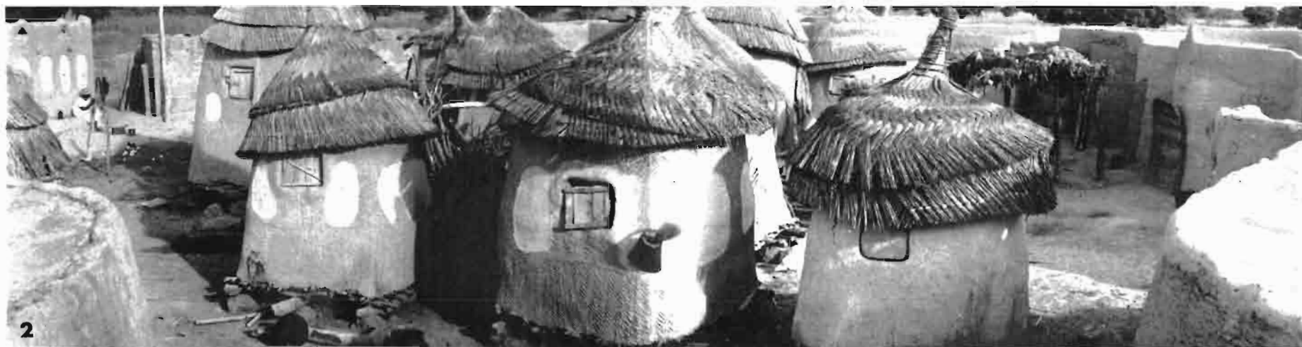
2. Entassement des greniers dans la cour d'un KÉLÉ.
