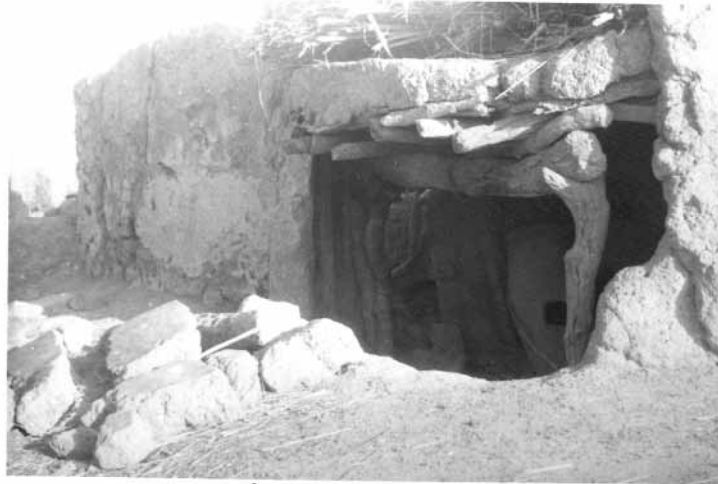
Entrée d'une ferme Kasséna
