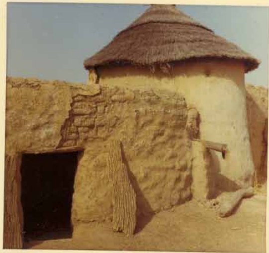
Entrée d'une ferme Kasséna
