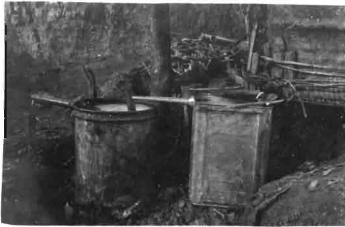
2 Essenciers "daba" - en série Remarquer le joint à la sortie du réfrigérant
