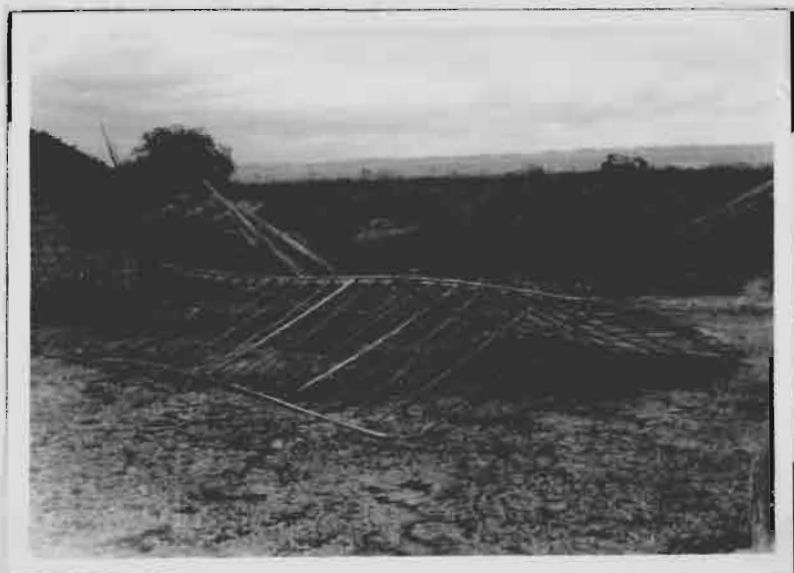
Photo 2 - Type de charpente pour toit en paille.
