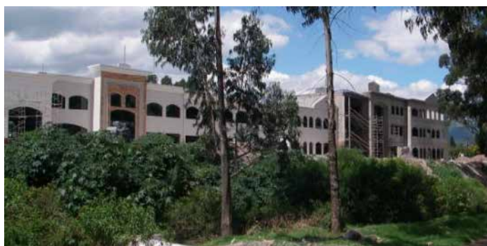
Photo 13 : Centre commercial en construction en bordure du Rio Santa Clara
