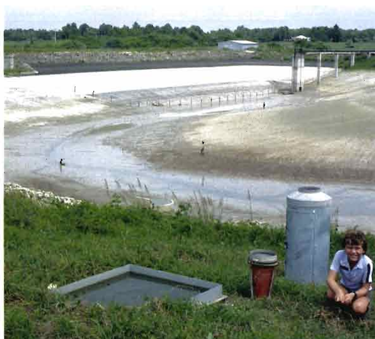
Retenue de Letaye-Amont en 1980.
