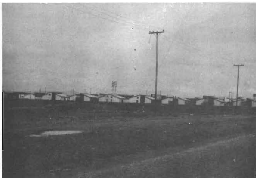
Ph.5. Une urbanización déjà ancienne, celle de Villa Adela.
