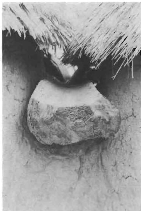
mándzáf gouttière entre deux cases
