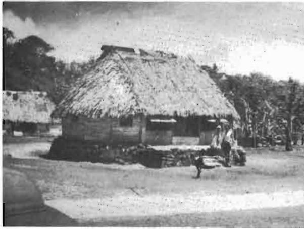
Photo 7. Type de case autochtone à Mota-Utu. Murs en planches et toit en feuilles de pandanus. Une plateforme en pierres la surélève et évite la pénétration de l'eau ou cours des fortes pluies. L'aération est médiocre et ce type de construction est peu salubre.
