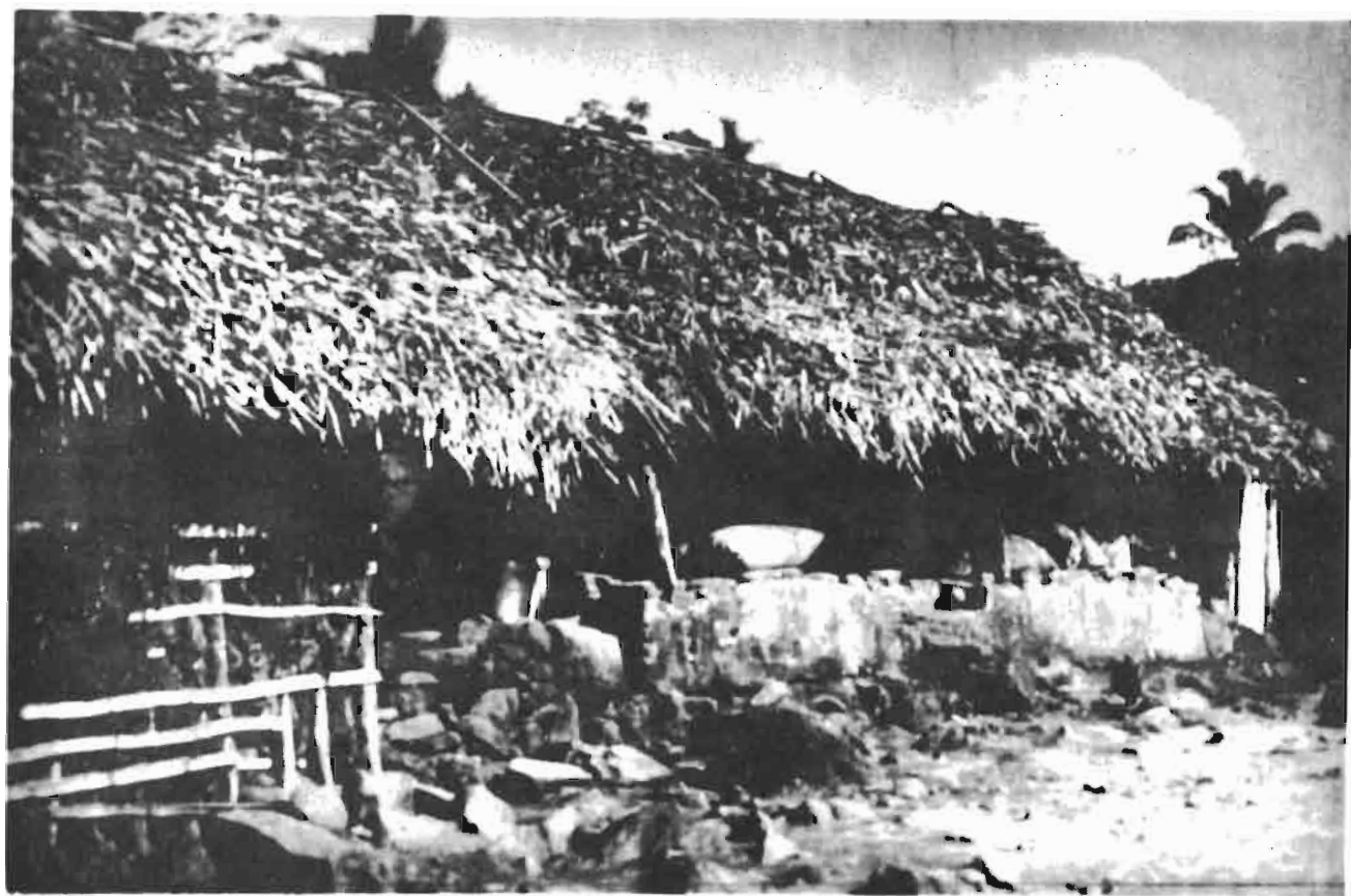
MAYOTTE. Case mahoraise du hameau de Mangajou. Remarquer l'armature en bambou de la case, le banco, le toit en ouanza, le sac de riz.
