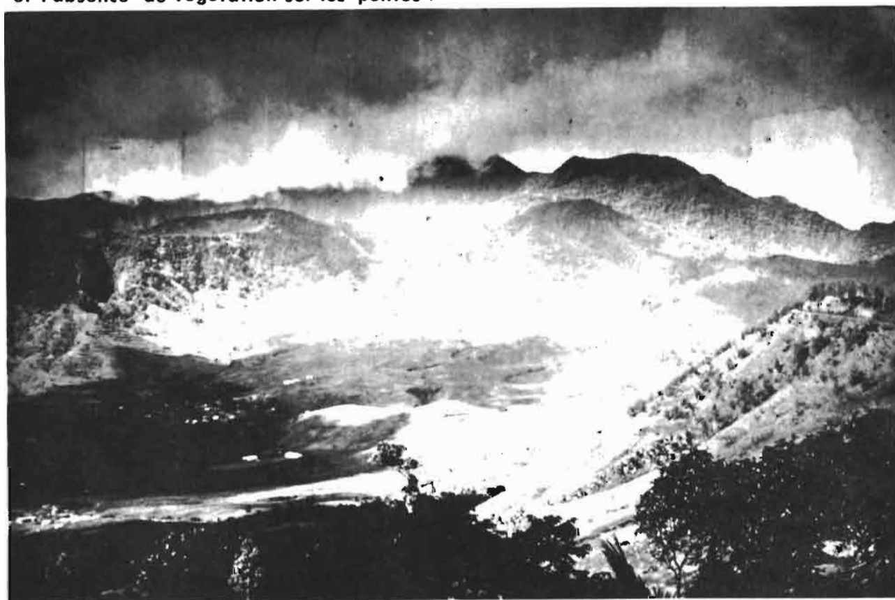
ANJOUAN . Le cirque de Bambao-M'Touni et le village de Tsimbéou . On remarque les gorges de la Tatinga . Au centre du cirque des bâtiments blancs de la "Bambao", à gauche le village de Chandra . Les pentes du N'Goniyagnombé, qui porte la route, cachent le village de Dindi ; au fond les pentes du N'Tingui , le pic est caché dans les nuages . Remarquer aussi quelques petites terrasses anti-érosives au-dessus de Tsimbéou .
