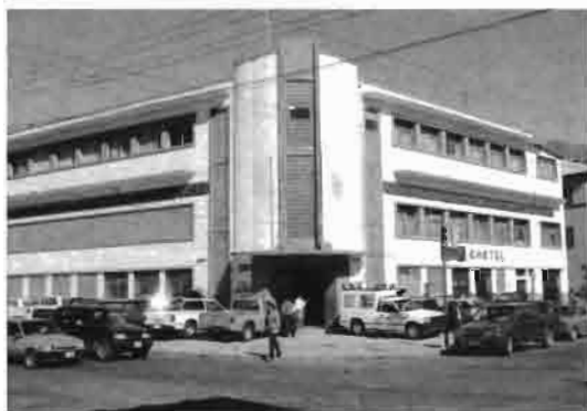
CENTRAL DE TELECOMUNICACIONES
