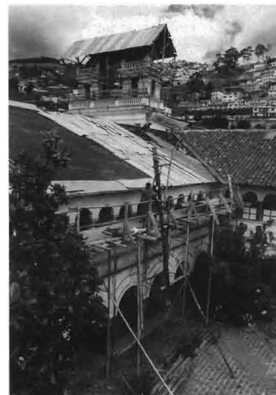
EDIFICACIONES DE ADOBE AFECTADAS EN EL TERREMOTO DE MARZO DE 1987
