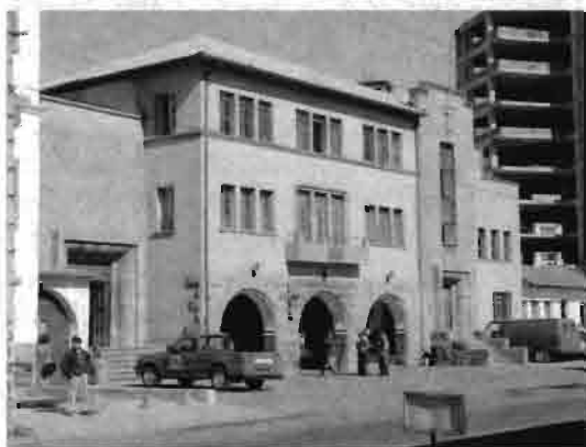
ESTACIÓN DE BOMBEROS
