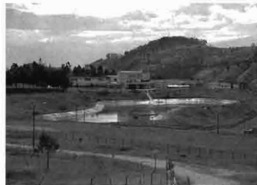
PLANTA DE TRATAMIENTO DE AGUA DE PUENGASÍ
