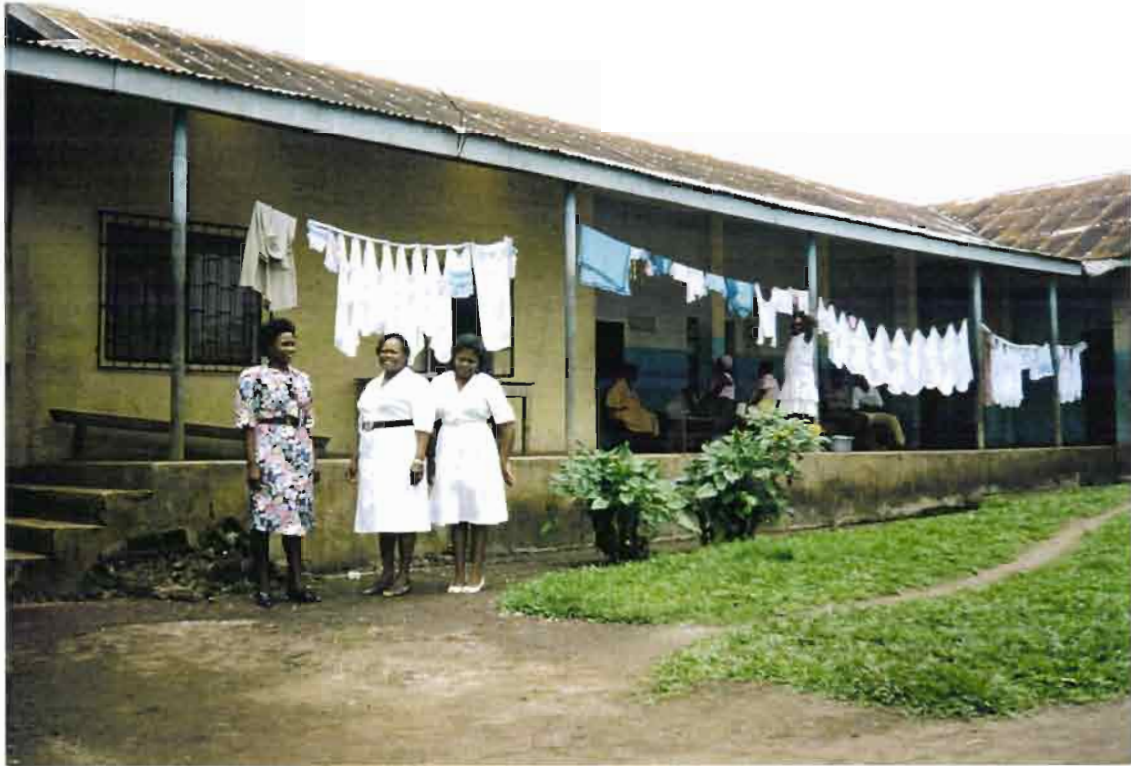
Photo n° 16 : Le centre de santé de la ville (Muea, août 1995).
